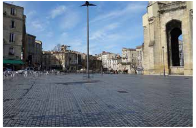
Place Saint-Michel à Bordeaux, Obras
