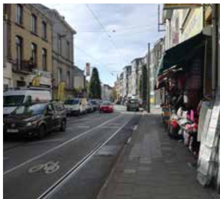
Chaussée de Neerstalle
