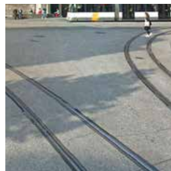
Béton désactivé du GIO et les rails du tram (même teinte que celui de la place)
