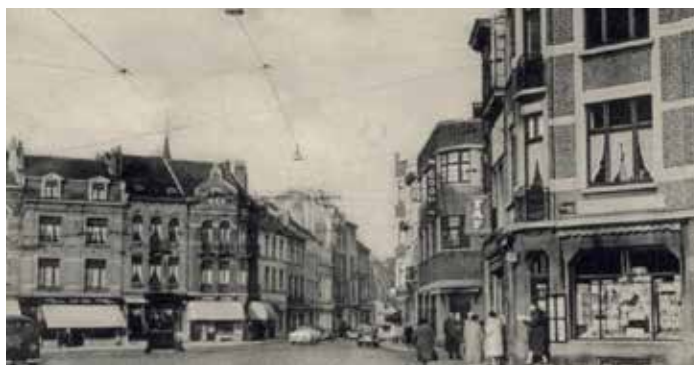
Chaussée de Bruxelles
