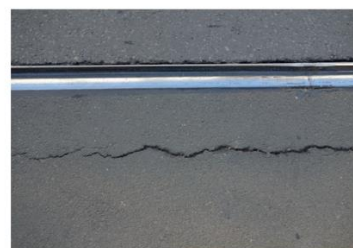
Asphalte avec rails - chaussée
