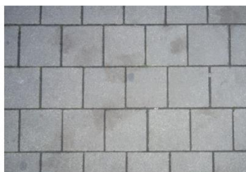
pavés béton - trottoir
