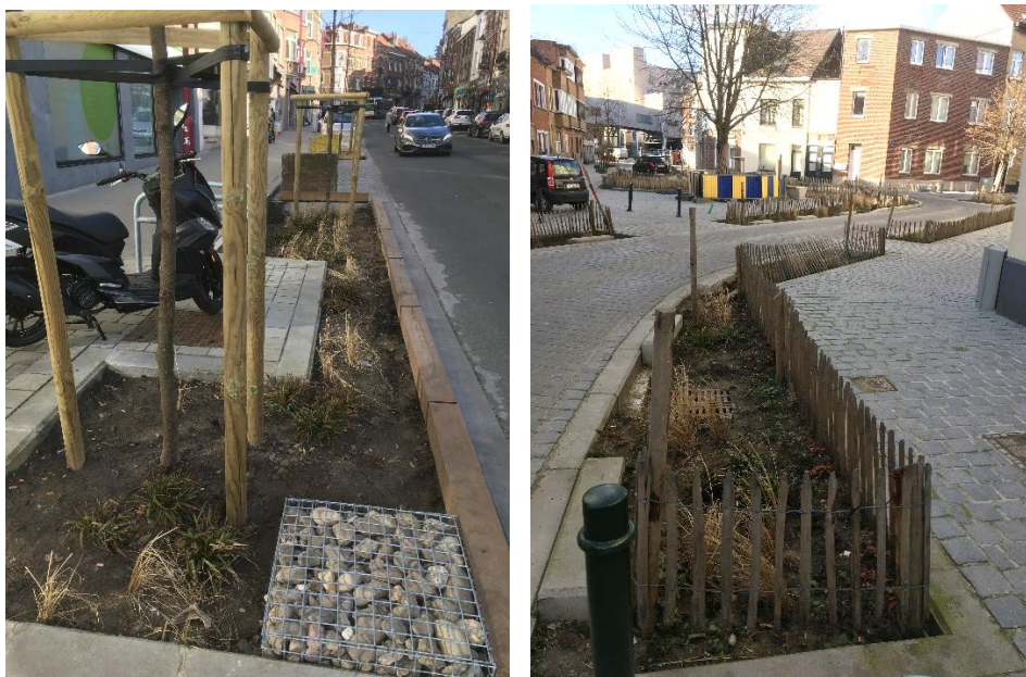
Figure 141 : Noues végétalisées sur la rue Jean-Baptiste Vanpé (à gauche) et rue de l'Eau (à droite) (ARIES, 2021)
