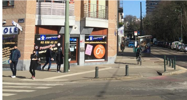
Figure 173 : Dalles podotactiles au carrefour chaussée de Bruxelles – rue Saint-Denis (ARIES, 2021)
