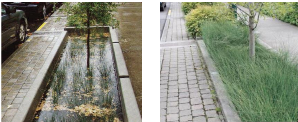
Figure 70 : Références de jardins de pluie par temps pluvieux (à gauche) et en temps sec (à droite) (A-Practice, 2021)
