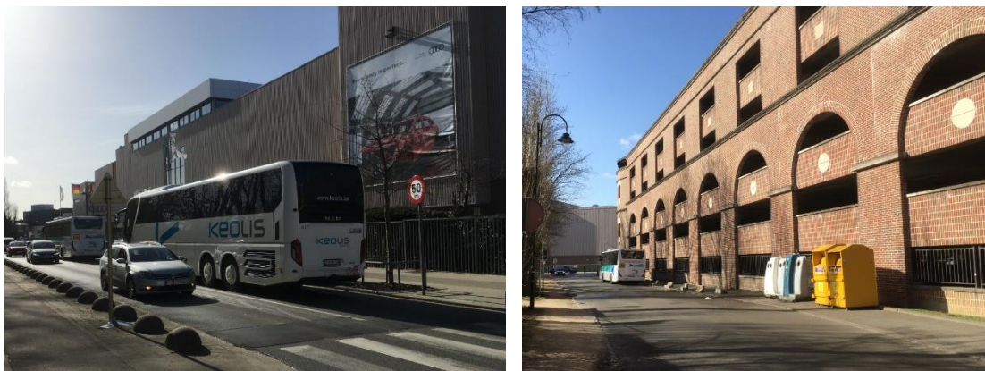
Figure 47 : Vue du bâtiment Audi (à gauche) et du parking d'Audi (à droite) (ARIES, 2021)
