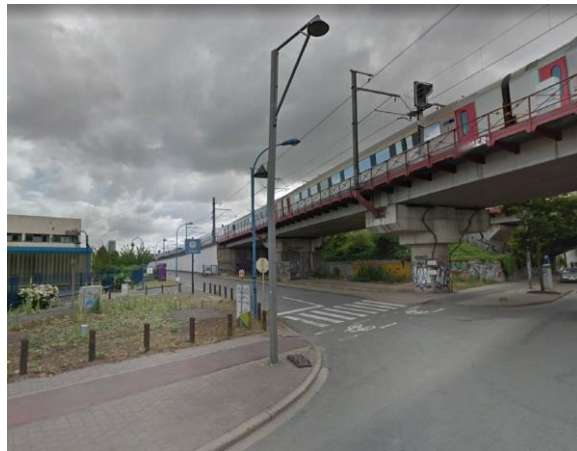
Toegang tot de site - Bestaande situatie - Google Maps | 2017
